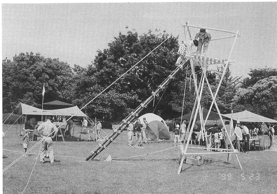
平成11年5月23日「のびゆく子どもの集い」で信号塔を建設
